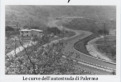
Le curve dell'autostrada di Palermo
