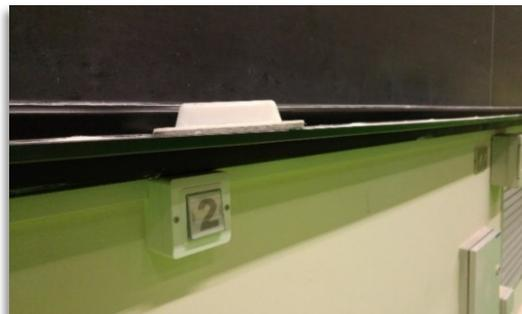
Figura 12: Pulsanti di richiamo per il puntamento della telecamera
